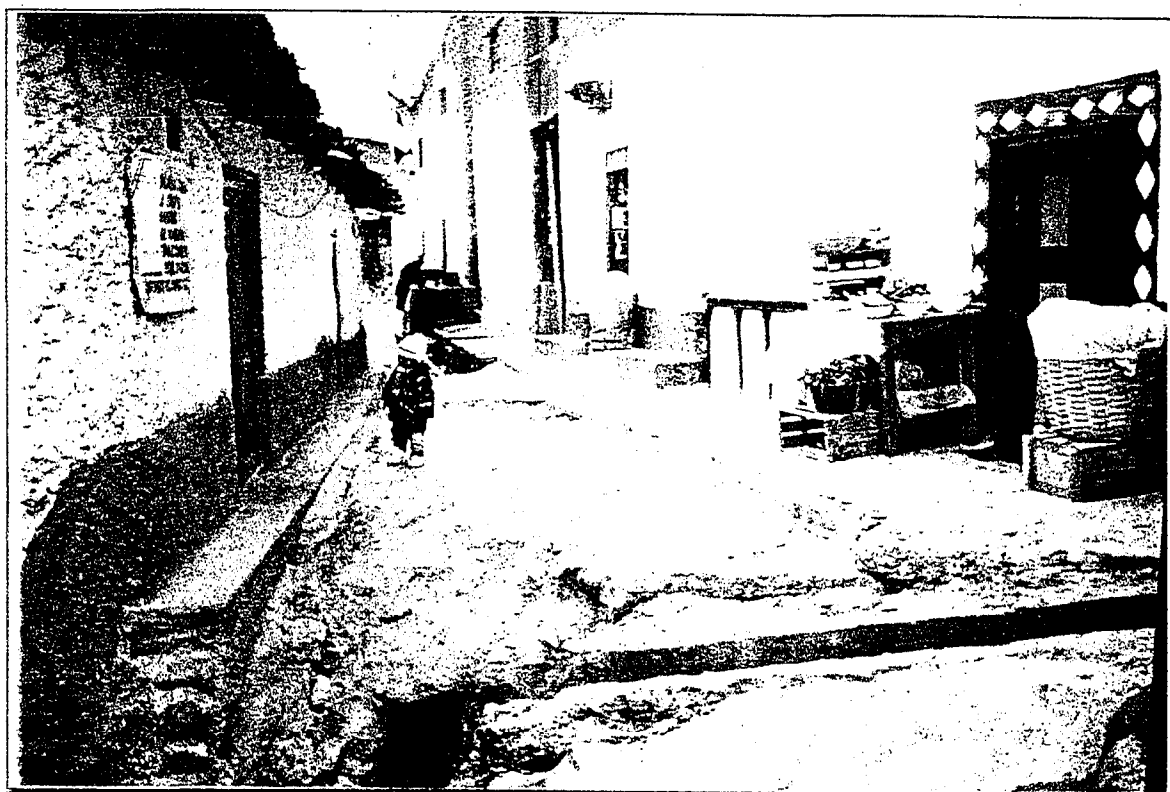
FOTO 2.3.1 / 10 EL SISTEMA DE ALCANTARILLADO ADMINISTRADO POR LA MUNICIPALIDAD, ESTRECHAS Y ANTIGUAS CALLES DE LA OROYA VIEJA, OBSÉRVENSE LAS CANALETAS ABIERTAS DE LOS DESAGÜES, LOS CUALES VAN DIRECTAMENTE AL RÍO MANTARO. SE EXPENDE ALIMENTOS JUNTO A LAS AGUAS SERVIDAS.
